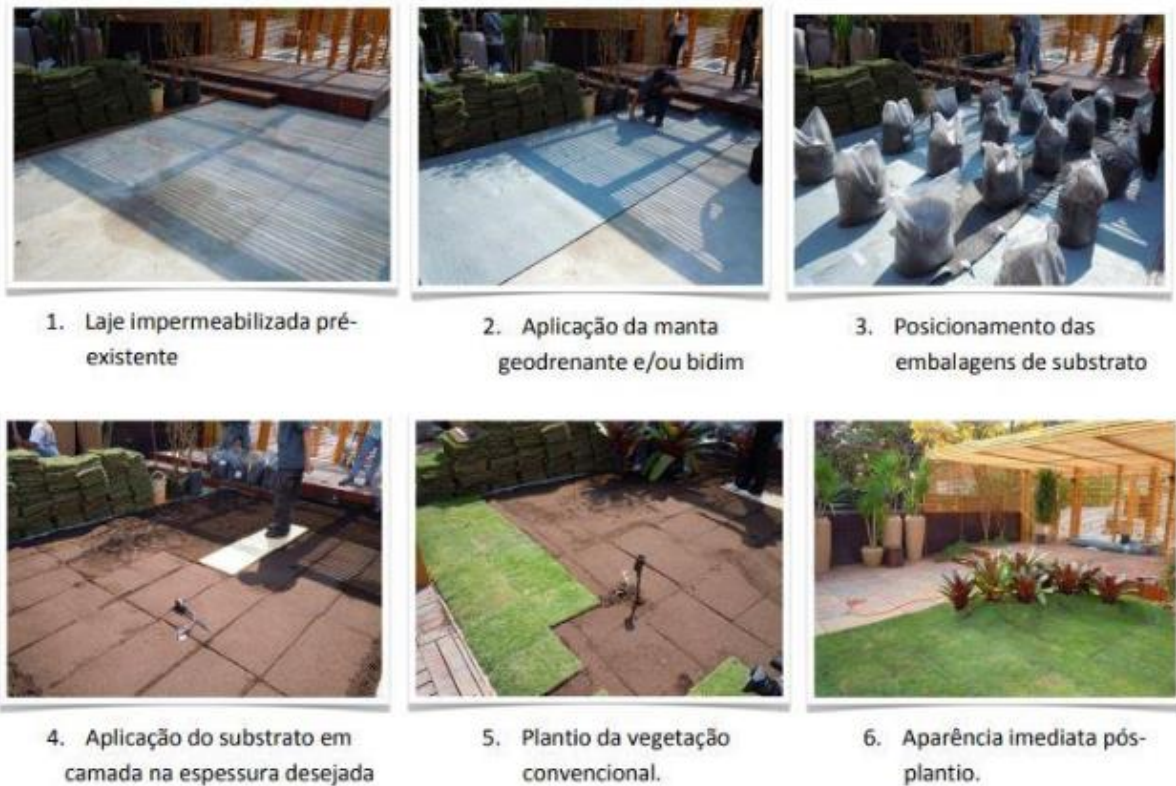
Figura 8 - Passo a passo da montagem do teto verde.
